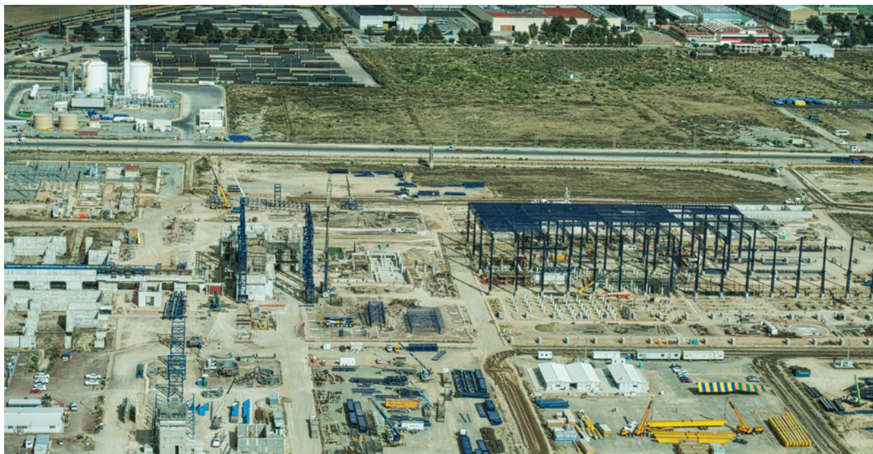
Gerdau segue investindo na construção de uma nova usina de perfis estruturais no México.
