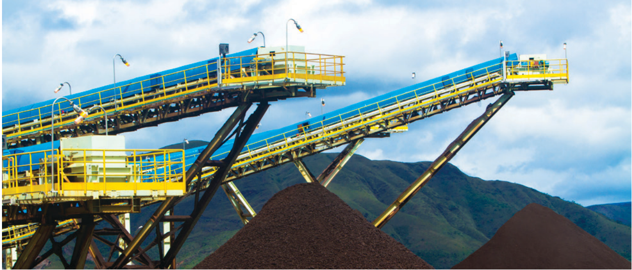
Segunda unidade de tratamento de minério de ferro entra em operação, ampliando capacidade de produção da Companhia.
