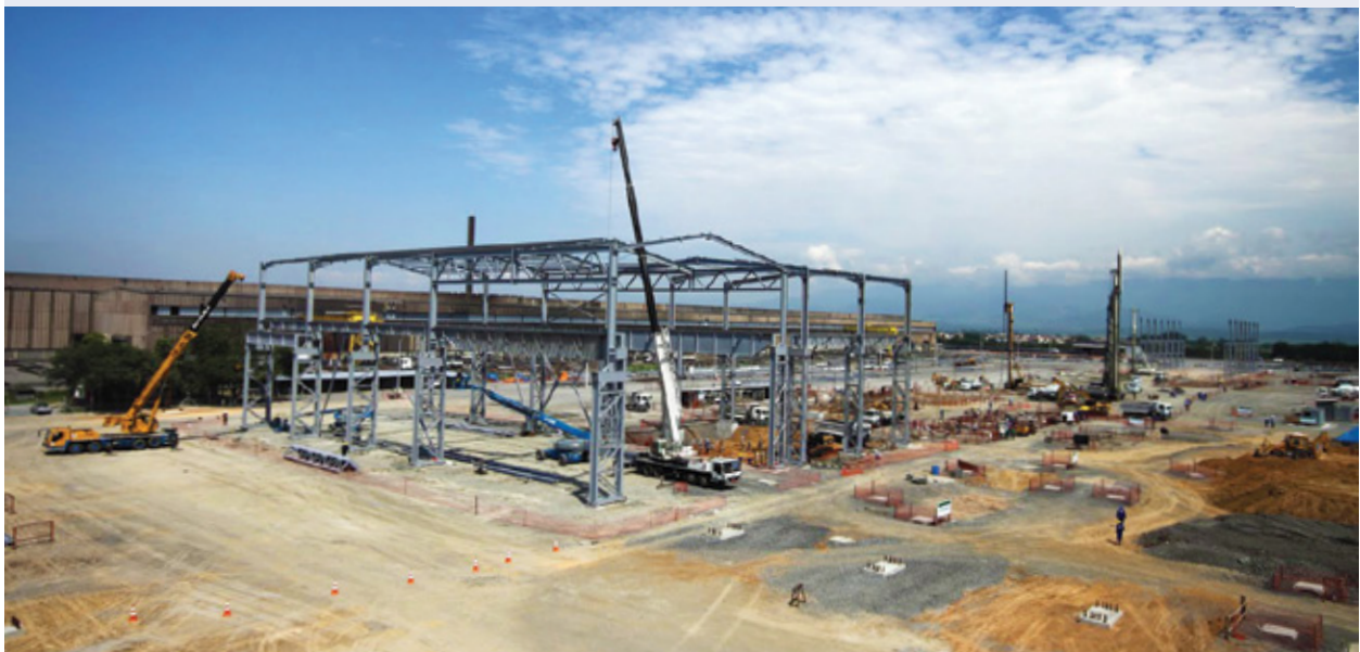
Na usina Pindamonhangaba (SP), serão instalados novos laminador de aços especiais, lingotamento contínuo e forno de reaquecimento
