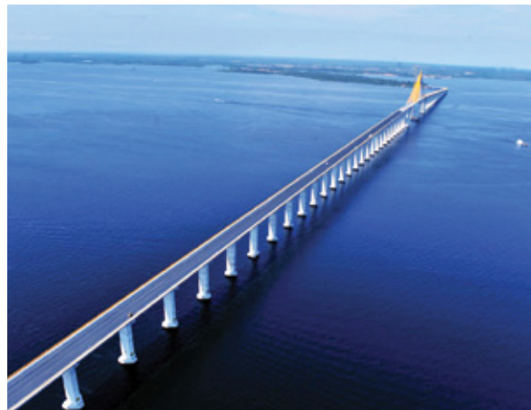
A Gerdau forneceu aço para a construção da ponte Rio Negro (AM), segunda maior ponte estaiada do mundo em águas fluviais
