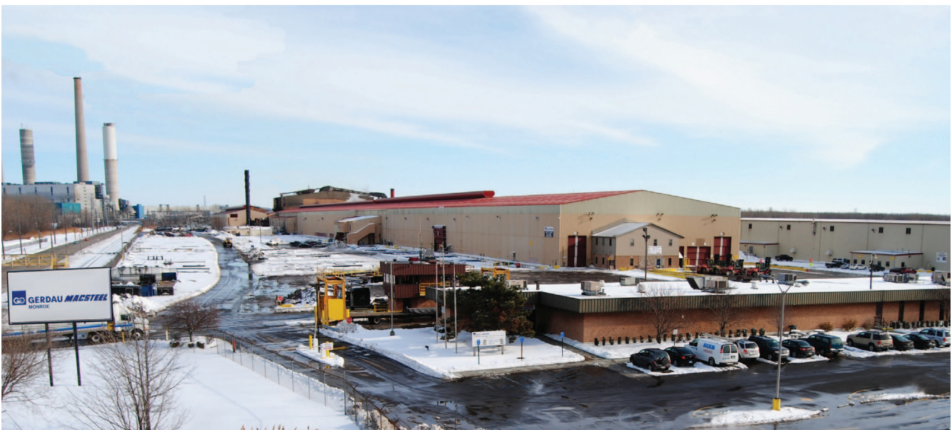
Usina da Gerdau Macsteel em Monroe (EUA) receberá investimentos para ampliar sua capacidade instalada
