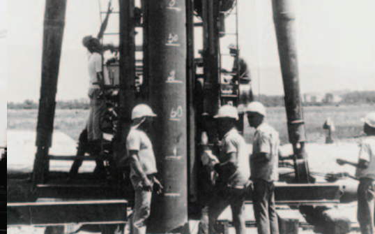
Construção da Gerdau Cosigua (RJ)
