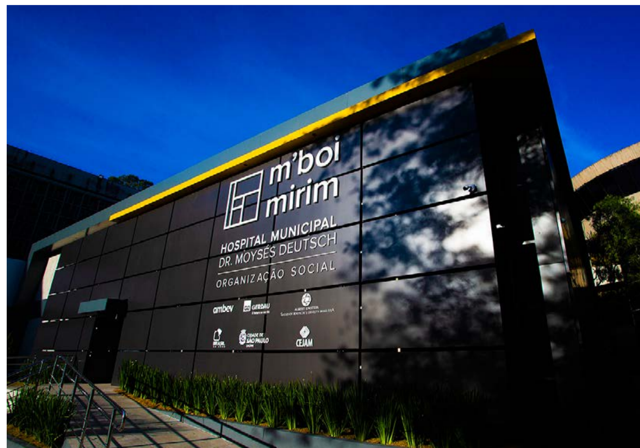
Centro de Tratamento à Covid-19, em São Paulo (SP), construído com recursos da Gerdau e empresas parceiras
