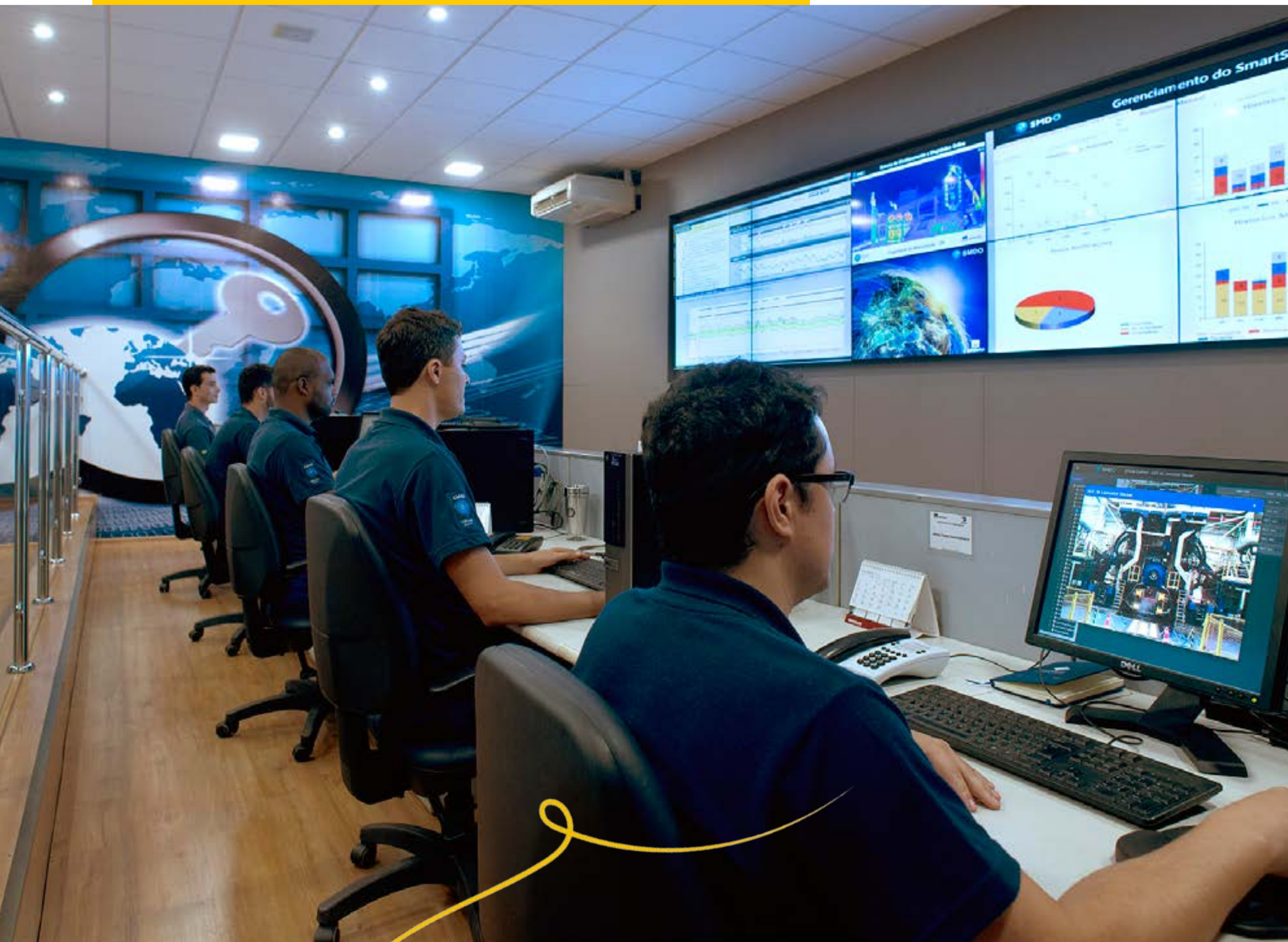
Sala de controle – Usina Gerdau Ouro Branco, MG
