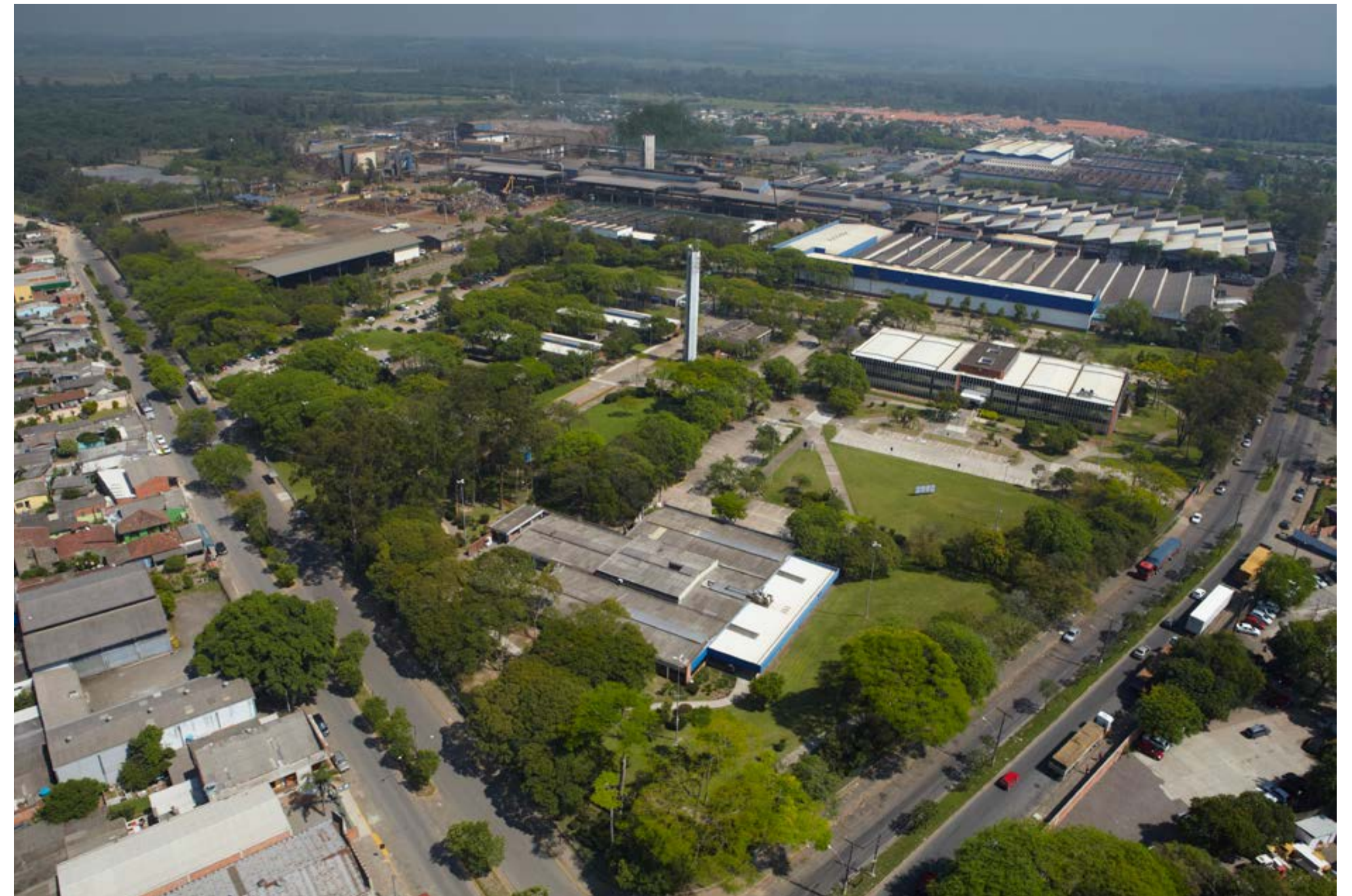
Usina Gerdau Riograndense, Sapucaia do Sul (RS)
