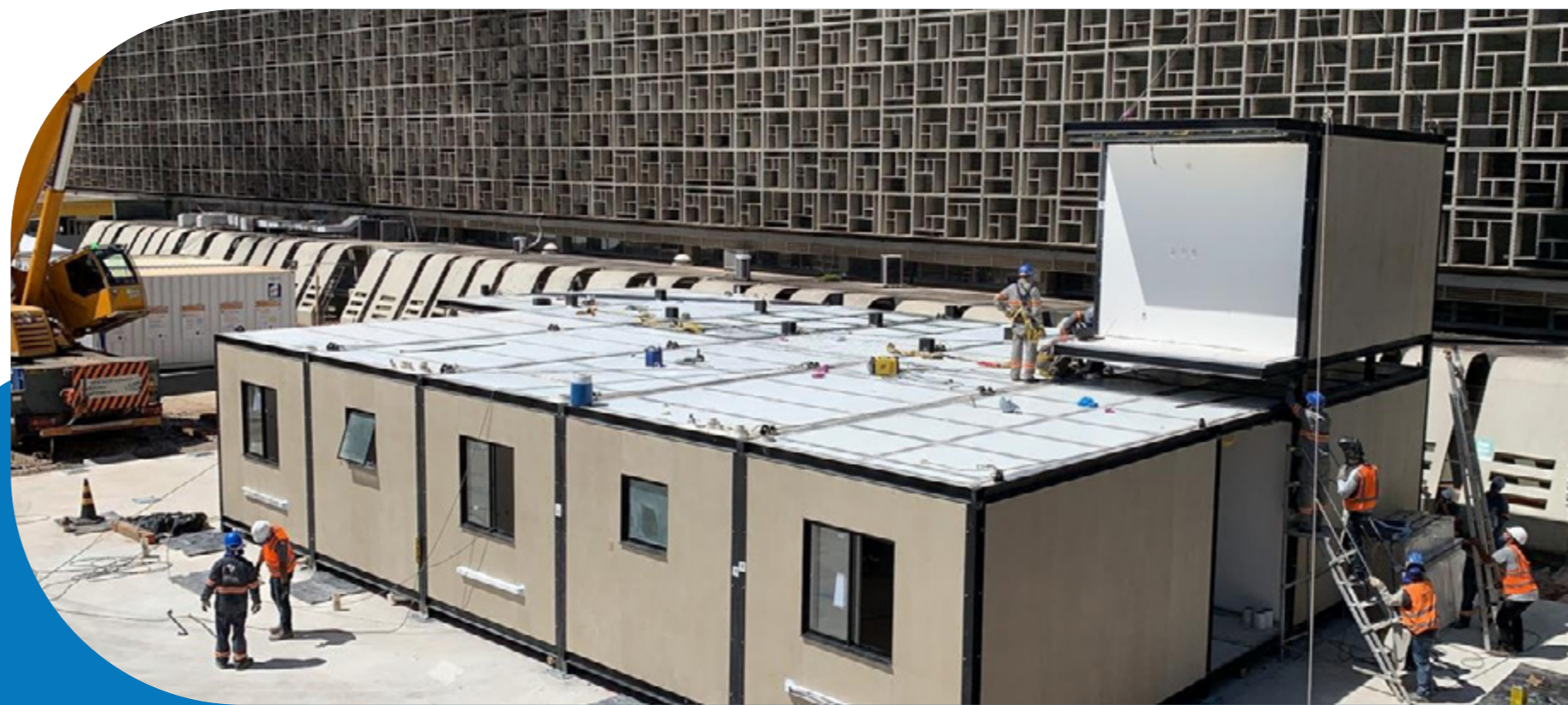
A técnica de construção modular da Brasil ao Cubo tem o aço como principal matéria-prima
